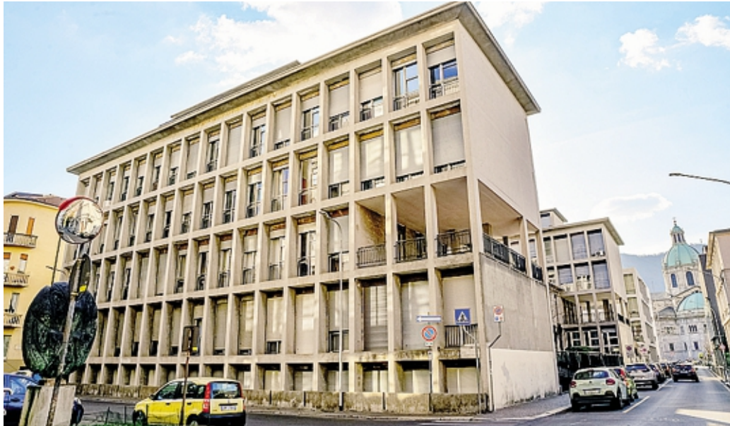
Una bella immagine del palazzo prima dell'avvio dei lavori di restauro ARCHIVIO
